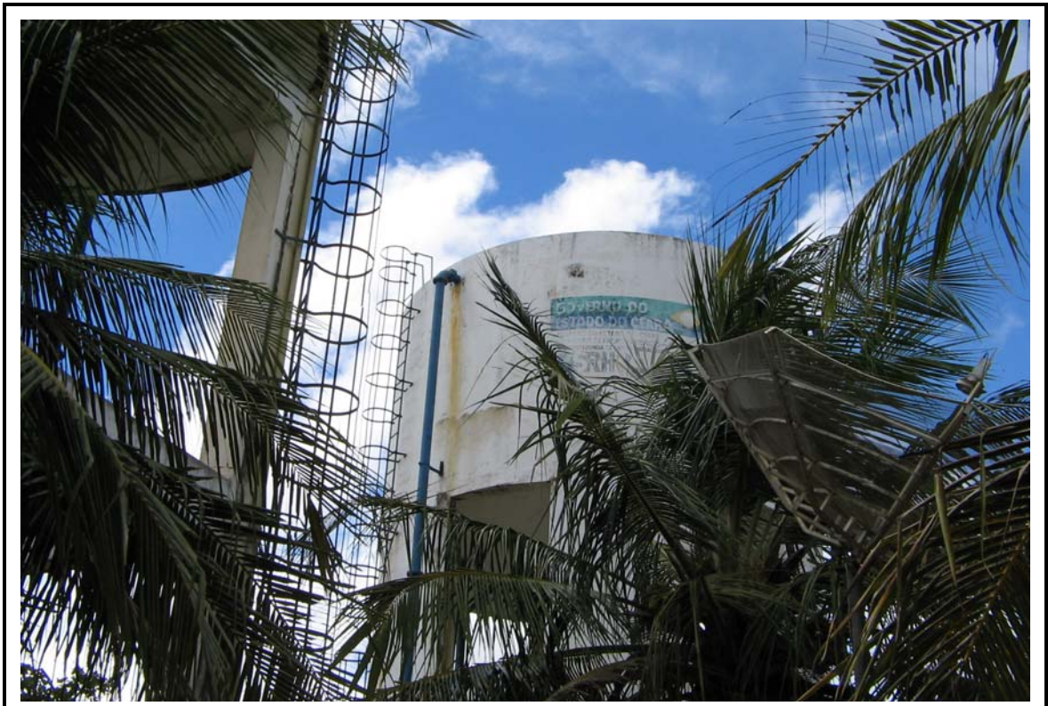
Foto 12 - Sistema de Abastecimento Chaval Barroquinha: Reservatórios Elevados de Barroquinha.
