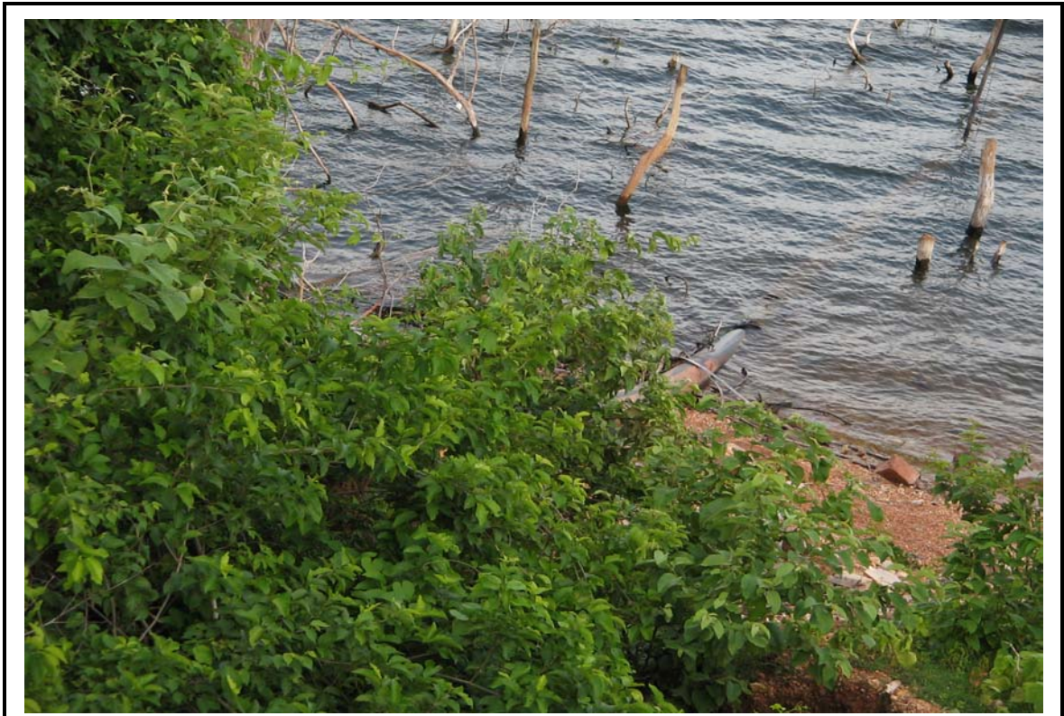
Foto 03 - Sistema de Abastecimento Chaval Barroquinha, ETA de Itaúna: Tubulação em PEAD, que liga o flutuante à ETA.
