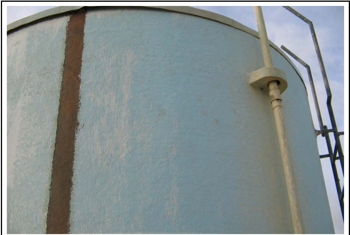
Foto 08 - Sistema de Abastecimento Chaval Barroquinha, ETA de Itaúna: Detalhe dos Filtros.
